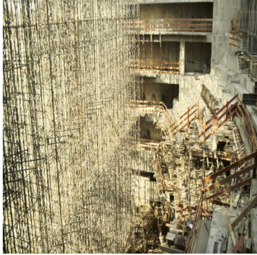
Février 1985 : les travaux débutent
